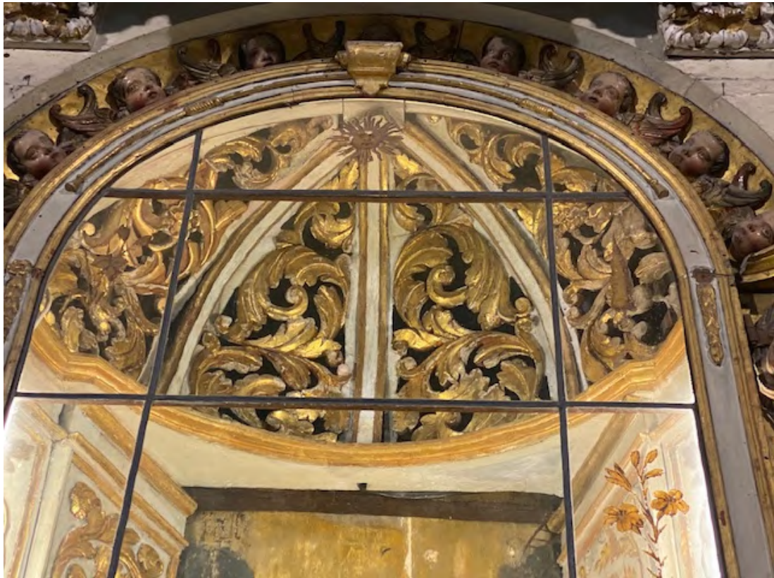
Cúpula una vez terminada su restauración.
