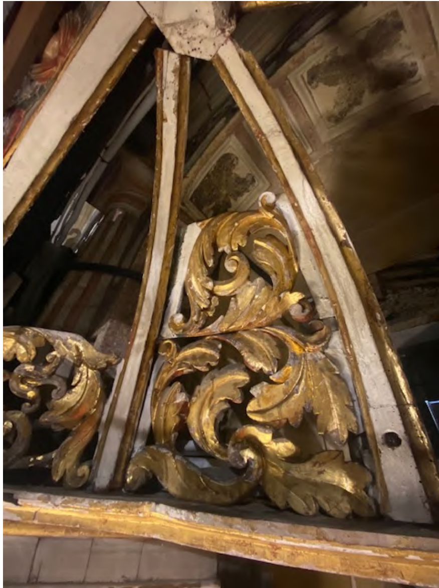
Reconstrucción de las piezas sueltas de la cúpula
