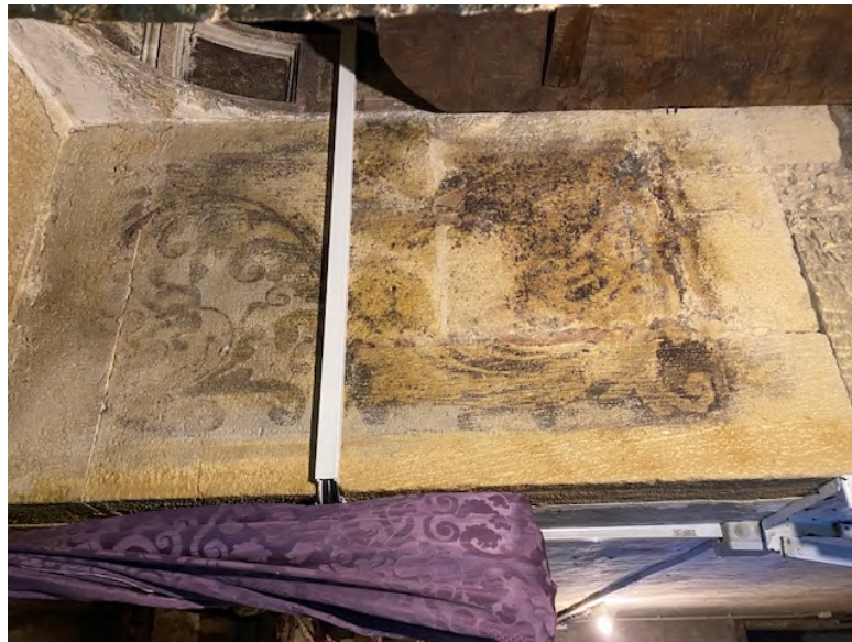
Detalle de las pinturas sobre piedra localizadas a ambos lados del acceso a la hornacina. Con policromía sentada y protegida.
