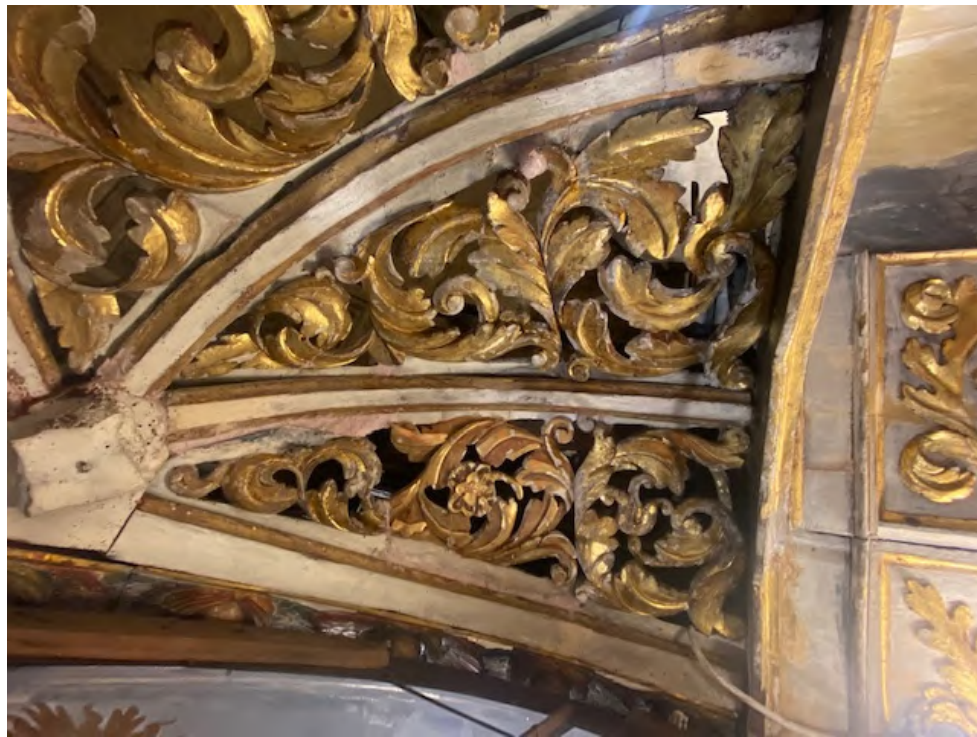
Cúpula con todas sus piezas colocadas, los oros fijados y limpia de barnices antiguos y polvo y suciedad
