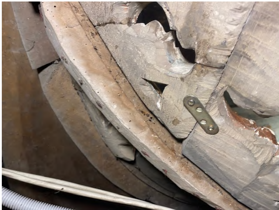
Parte de atrás de la cúpula con piezas unidas por pletinas y la madera desinsectada y limpia
