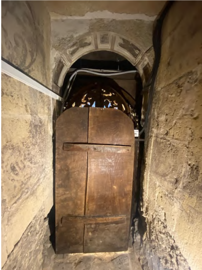
Vista del reverso del panel con la madera limpia, desinsectada y barnizada
