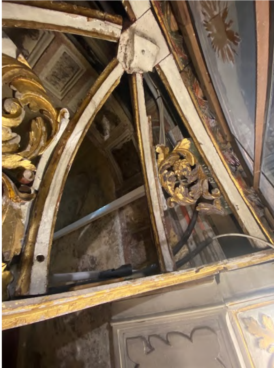
Proceso de reconstrucción de las piezas doradas de la cúpula
