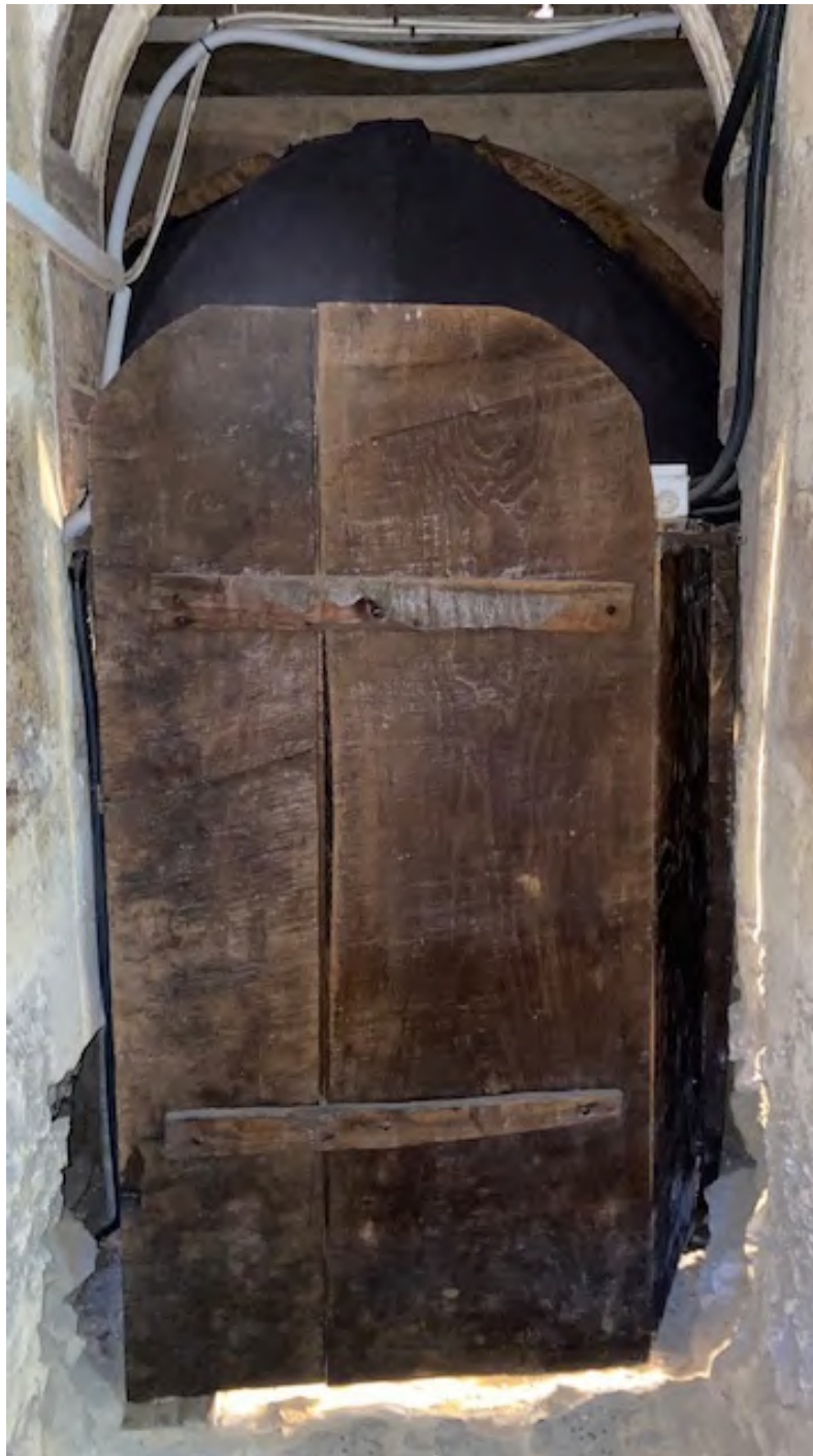
Estado de la hornacina por la parte trasera del retablo, al finalizar los tratamientos de restauración.
