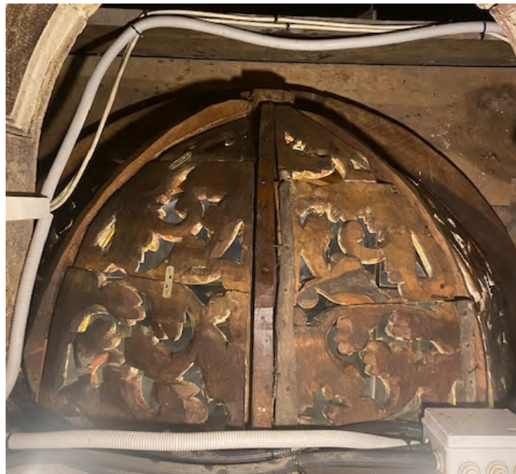
Aspecto de la zona trasera de la cúpula con la madera limpia y protegida con barniz
