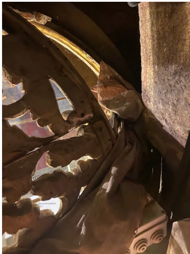
Vista de la cúpula con la tela que lo cubría, rota, descolorida y debilitada
