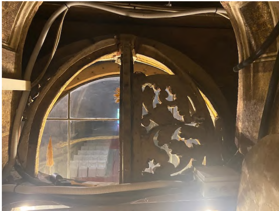
Desmontado de la tela trasera para comenzar a reconstruir la cúpula
