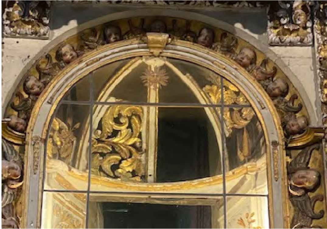
Aspecto de la cúpula de la hornacina en medio proceso de reconstrucción
